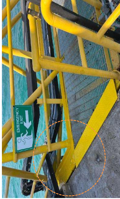
ก่อน ข้อบกพร่อง / ความเสียหาย : โครงสร้างเหล็กโครงสร้างผูกมัดทุกระเบือน เป็นสนิมขาดเสียหายรุนแรง แก้ไขปรับปรุง : ทำการซ่อม เปลี่ยนโครงสร้างเหล็กที่เสียหายทันที
