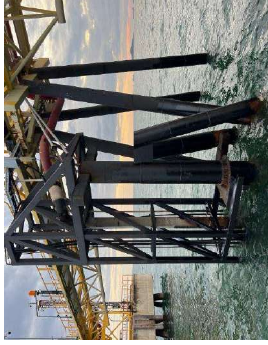
ก่อน ข้อบกพร่อง / ความเสียหาย : โครงสร้างเหล็กโครงสร้างผูกมัดทุกระเบือน เป็นสนิมขาดเสียหายรุนแรง แก้ไขปรับปรุง : ทำการซ่อมแซม ปรับปรุงเปลี่ยนโครงสร้างเหล็กที่เสียหาย
